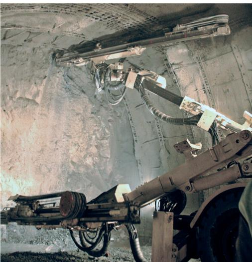
С бурения шпуров с помощью вращательно-ударных гидравлических перфораторов начинается каждый новый цикл процесса добычи полезного ископаемого и обеспечивает высокую эффективность метода.
